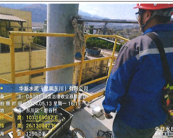
DA081 固废治理收尘器排放口 (FQ14#)
